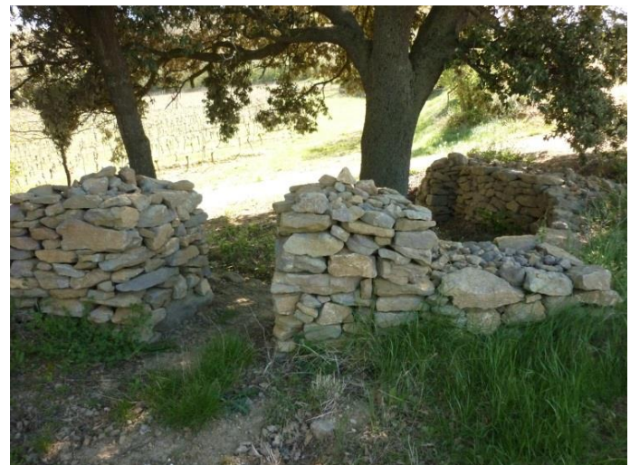
▲ Muret à la Digne d'Amont
