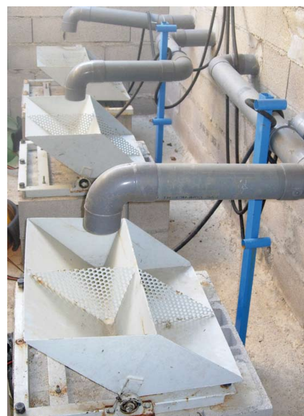
Dispositif de récupération des eaux de drainage Photo IFV L. Gontier
