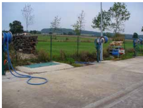
Aire de lavage de Péronne - Photo Chambre d'Agriculture de Saône-et-Loire
